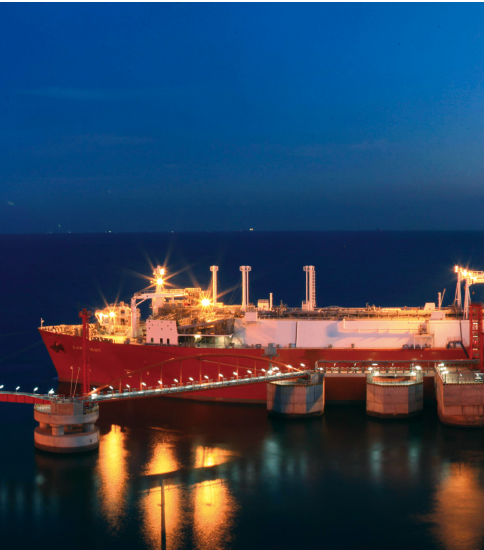
Dalian LNG Terminal
